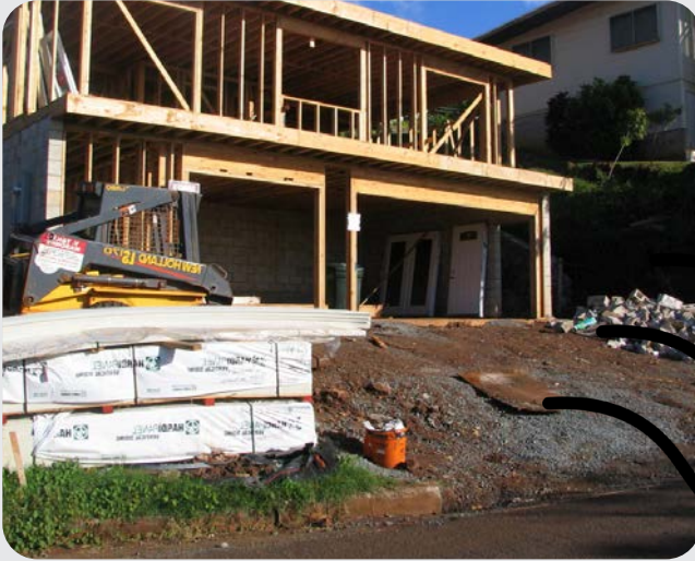
施工项目使土壤暴露。
