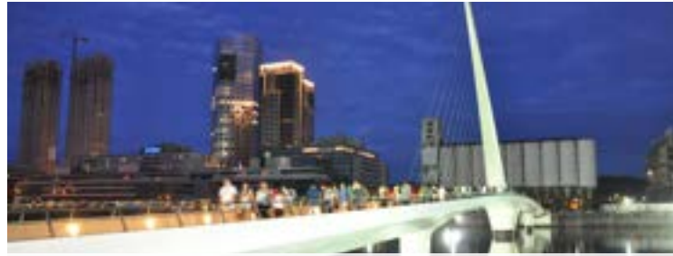
PUENTE DE LA MUJER, SEVILLE, SPAIN
