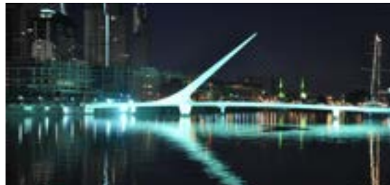
PUENTE DE LA MUJER, SEVILLE, SPAIN
